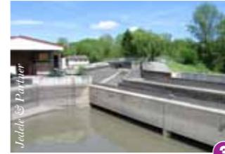
Kläranlagen werden aus wirtschaftlichen Gründen auf eine bestimmte Wassermenge ausgelegt. Bei stärkeren Regen füllen sich die Kanäle und das Abwasser wird in den Regenüberlaufbecken (RÜB) zwischengespeichert. Läuft das RÜB über, gelangt der Überlauf direkt in das Gewässer. Am **RÜB Mariatal** der Stadt Ravensburg wird ein Teil des Überlaufes versuchsweise über einen Lamellenklärer geleitet, um den Feststoffrückhalt zu verbessern.
