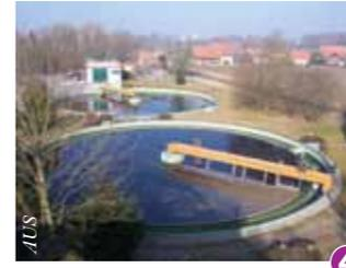
Die **Kläranlage Eriskirch** des Abwasserverbandes Unteres Schusental (AUS) erhält versuchsweise eine Ozonbehandlung vor dem vorhandenen Sandfilter und danach eine Aktivkohlebehandlung mit Kornkohle. Mit dieser Kombination lassen sich Keime und Spurenschadstoffe entfernen.
